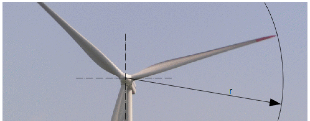
11: Rotor větrné elektrárny Vestas V90 s výškou sloupu 105 m, průměrem rotoru 90 m a instalovaným výkonem 2 MW. Drahaný (CZ).
