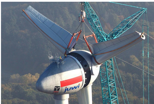
Montáž rotoru větrné turbíny Enercon e-126 s dělenými lopatkami
